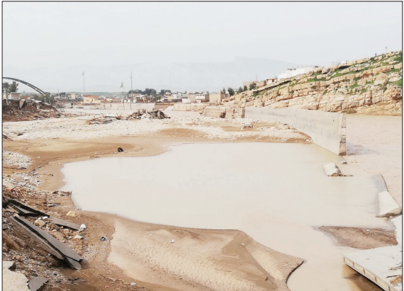
شکل ۳- احداث دیواره بتنی در بستر رودخانه و محدود کردن عرض عبور جریان
