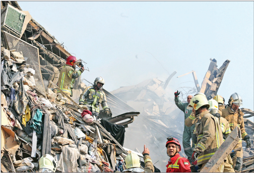
حادثه آتش‌سوزی در ساختمان پلاسکو
